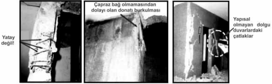
Şekil – 5 22 Temmuz 1967 depreminden sonra binada olan yapısal ve yapısal olmayan ağır hasarlara tipik örnekler
