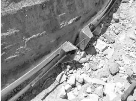
Şekil 7 Çekme çemberi detayları.
