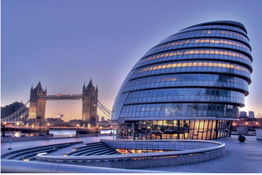
Resim 1 - Londra'daki yeni yapılan belediye binası bilgi teknolojilerinin tasarım ve mühendislik aşamalarında yoğun olarak kullanıldığı bir yapıdır 3 .
