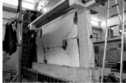
%2.75 - dış duvarın diyagonal kemerlenme ve kesme kayması ile karışık hasar modu.
