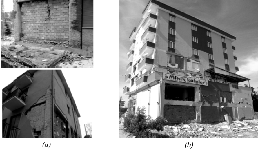
Şekil 2. (a) L'Aquila [4], (b) Van depremi alt ve orta katların sandviç duvar hasarları.
